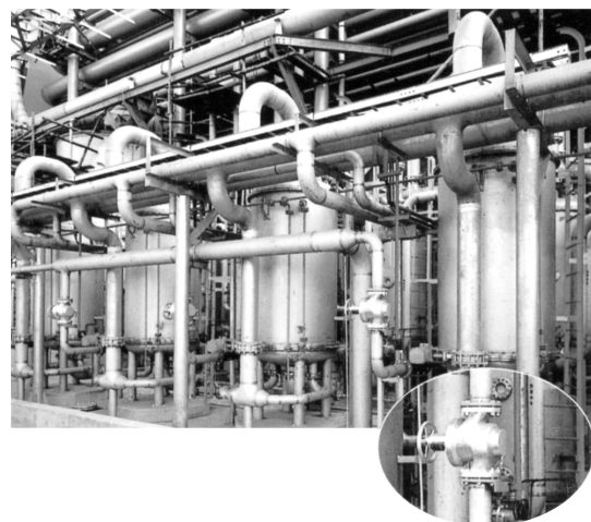
写真3 UFS型の配管設置例
